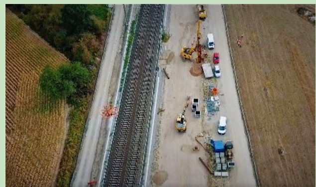
Einsatz moderner Baustellenlogistik / Projekt KaBa
