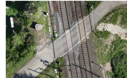
Quelle: DB Netz AG
